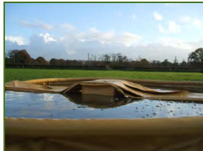
Coloque la cubierta uniformemente sobre el depósito hasta que esté centrada, con la sección de flotación en contacto con el agua.
