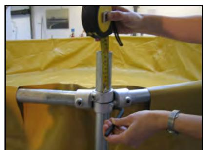
Compruebe que los conectores giratorios en la parte superior del poste se fijan en la altura y ángulo correcto. La altura correcta es de 100 mm desde la parte superior, como se ilustra arriba. El ángulo correcto se establece a ojo utilizando el borde de la base del forro de guía
