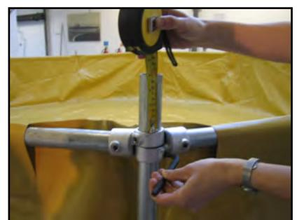
Assurez-vous que les connecteurs à tête d'injection du haut sont placés à la bonne hauteur et au bon angle. La bonne hauteur est à 100mm depuis le haut comme l'indique la photographie ci-dessus. Le bon angle est établi à vue d'œil en utilisant le bord de la base de la membrane comme guide.
