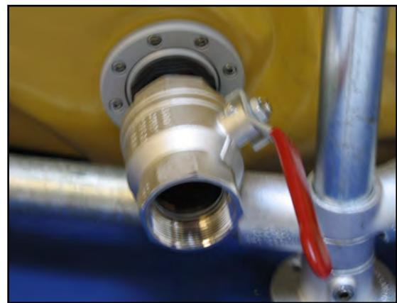
12. Schließen Sie alle Rohrleitungen an, die zusätzlich zu dem gelieferten Bausatz erforderlich sind.
